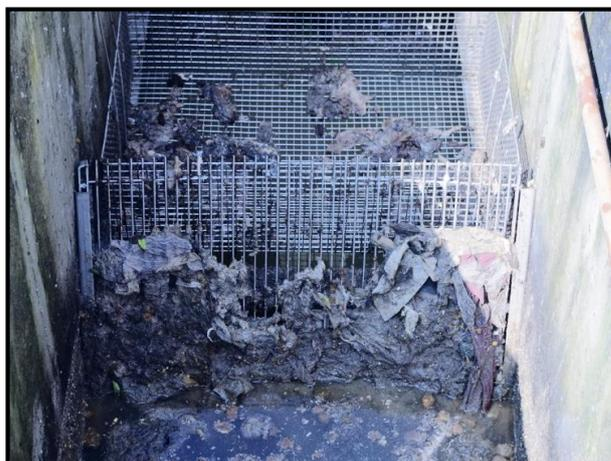
Photo des déchets retrouvés sur les grilles à l'entrée des bassins de lagunage. Photo D.L.
